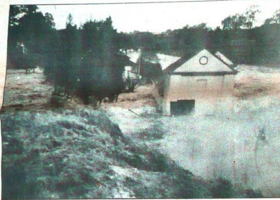
Rio Potiribú inundou Usina de Sede
