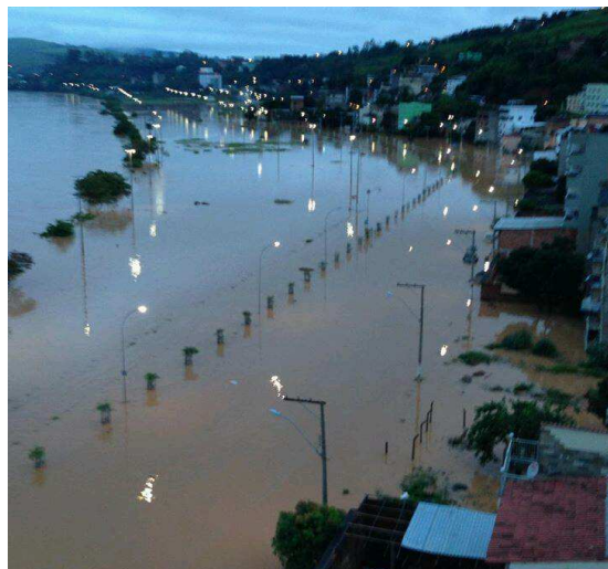
Figura 3. Av. Beira Rio durante a inundação Fonte: Google Imagens. Junho de 2014
