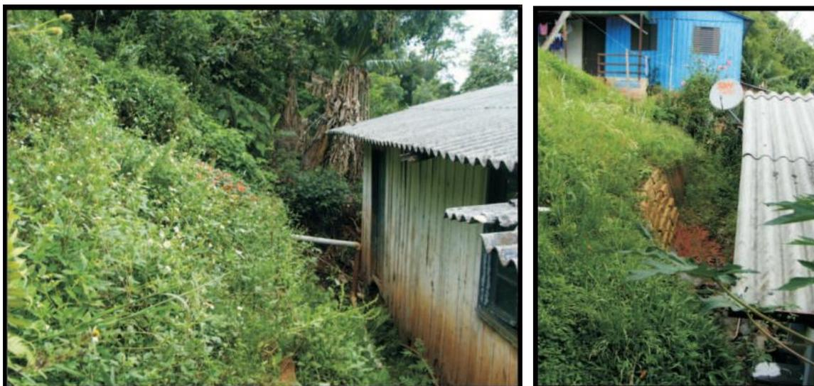
Figuras 3 e 4- Residências em área de risco próximas a corte realizado no solo.
