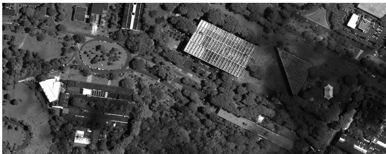
Figura 4 – Edificações localizadas no centro da ortoimagem.
