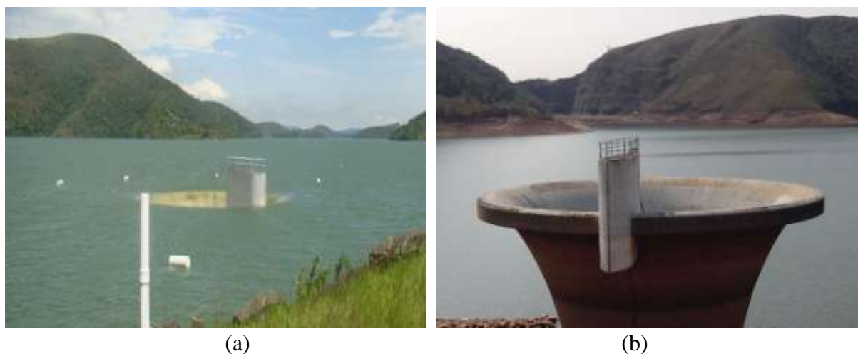
Figura 5- Fotografias do extravasamento da represa de Paraibuna pela Tulipa: (a) em 2010; (b) em 2014.
