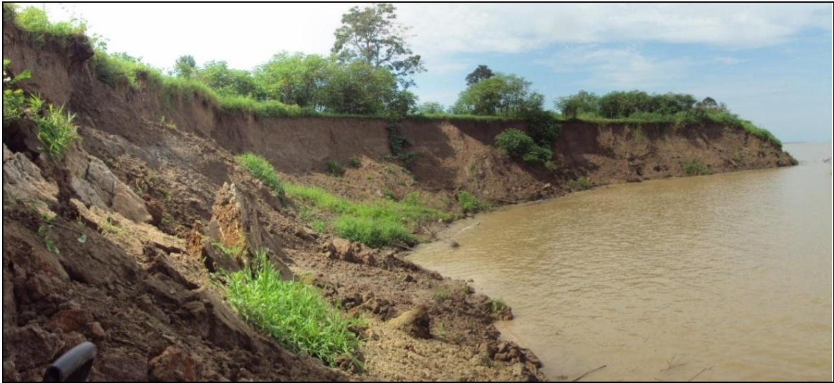
Figura 2. Zona de erosão na área 1, próximo ao município de Iranduba na margem direita do Rio Solimões.
