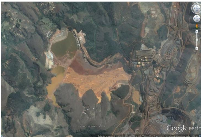
Figura 1 - Barragem de rejeitos e resíduos Maravilhas II.
