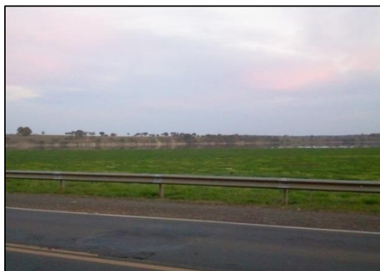
Figura 1 - Macrófitas emersas na ponte da Rodovia SP-191 sobre o Rio Tietê (agosto de 2014)
