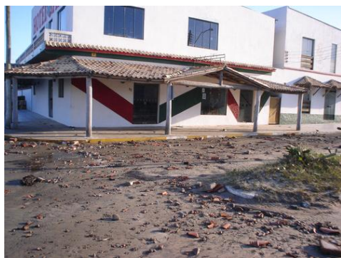
Figura 7 – Registro fotográfico dos efeitos de uma onda de ressaca sobre área urbana no ano de 2010
