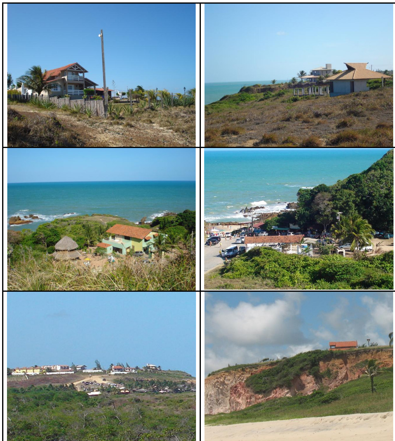
Figura 5. Imagens com áreas que apresentam construções edificadas dentro da APP.
